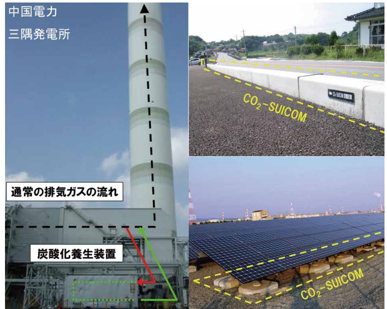
CO 2 -SUICOM炭酸化養生装置と適用先
