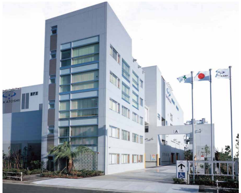
電力消費の節電に取り組み二酸化炭素排出量を削減した東京臨海エコ・プラント
