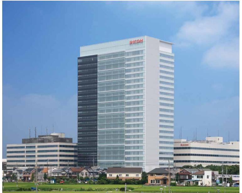
省エネルギー施策実施の建築物
