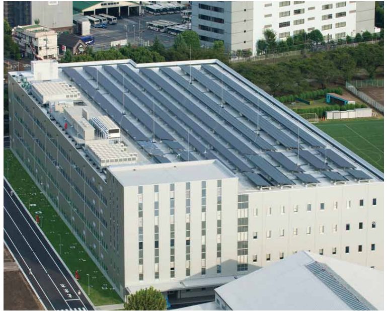
太陽光発電設備の導入
