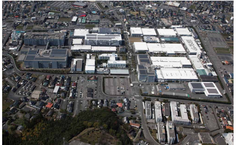
メガソーラー設置によるCO 2 削減
