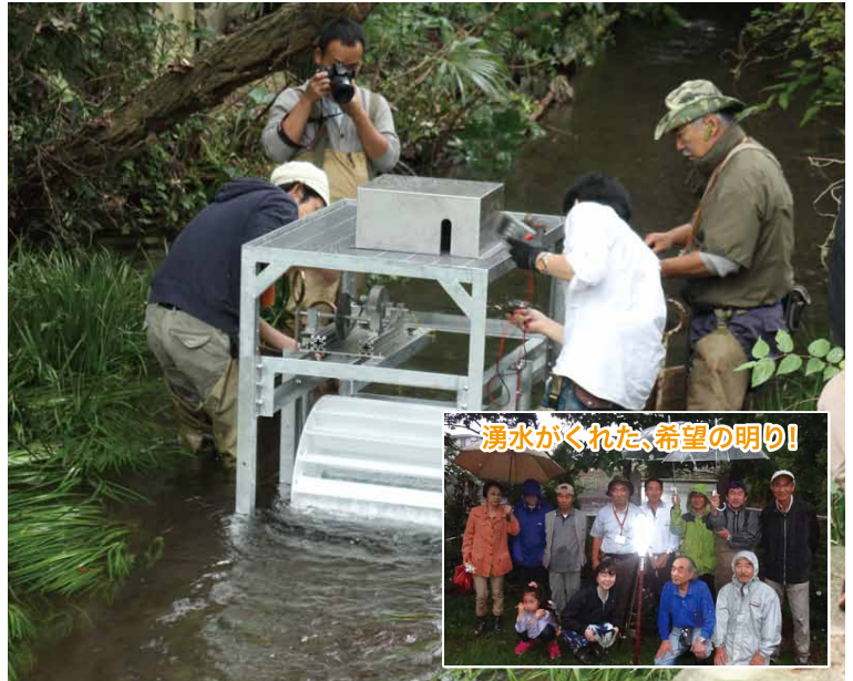
湧水小水力発電機の据付け作業中
